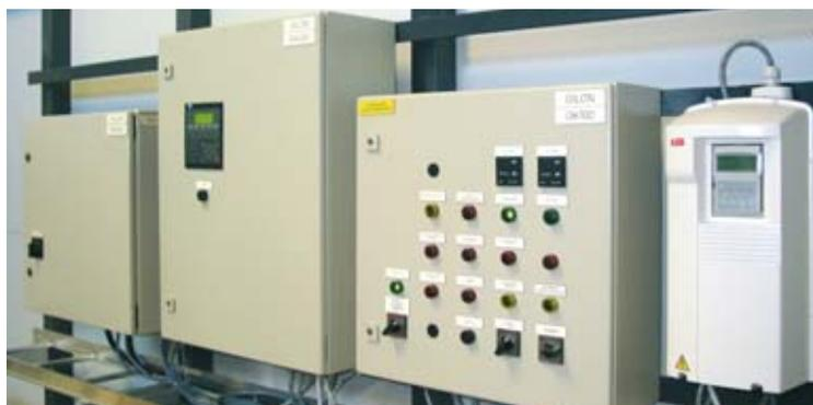
Полностью автоматическая регулировка по кислороду (O<sub>2</sub>)/перепад давления/каскадная регулировка
