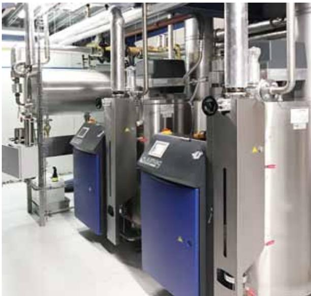
*Abb.: Mehrfachdampfanlagen, modulare Ausführung*
