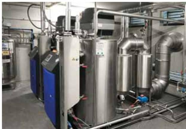
*Abb.: Mehrfachdampfanlage. Zweiter nachgeschalteter JUMAG Economiser platzsparend auf Grundgestell installiert*
